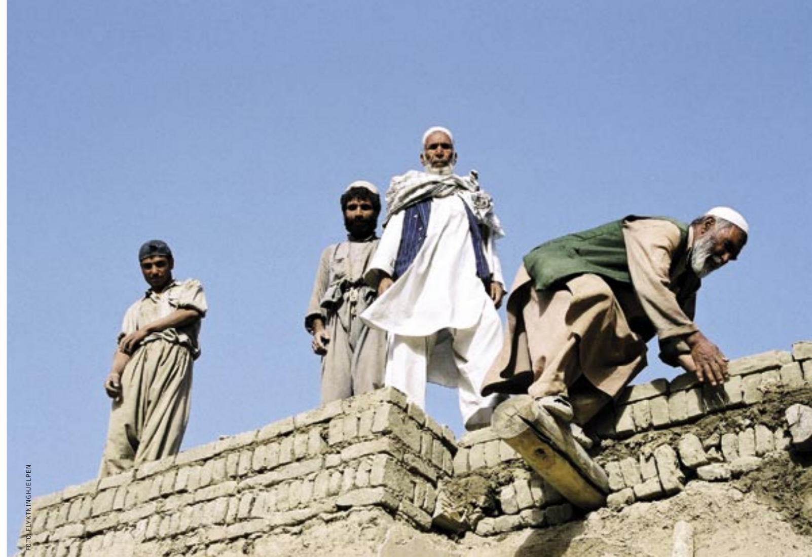
Husbygging i Pakistan.
